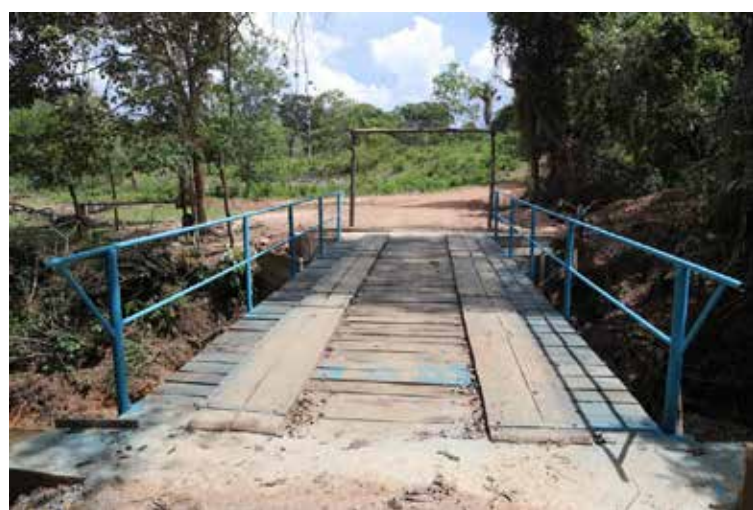
Ponte sobre o Rio Riachão
