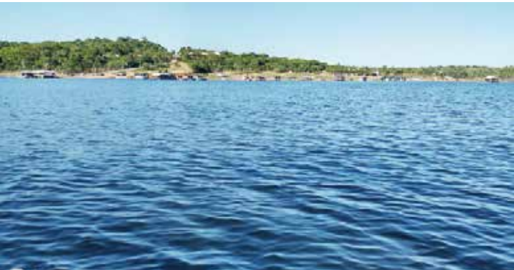
RESERVATÓRIO DE SERRA DA MESA
