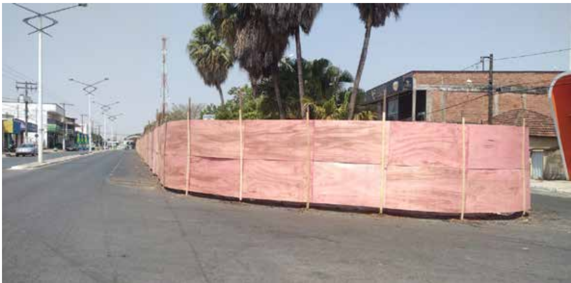
Obras de reconstrução da Praça Castro Alves já estão iniciando a todo vapor
